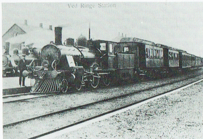
Ved Ringe Station
